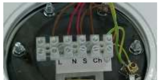
Рис. 3 Фото. Колодка подключения встроенного термостата бойлера STOUT.
